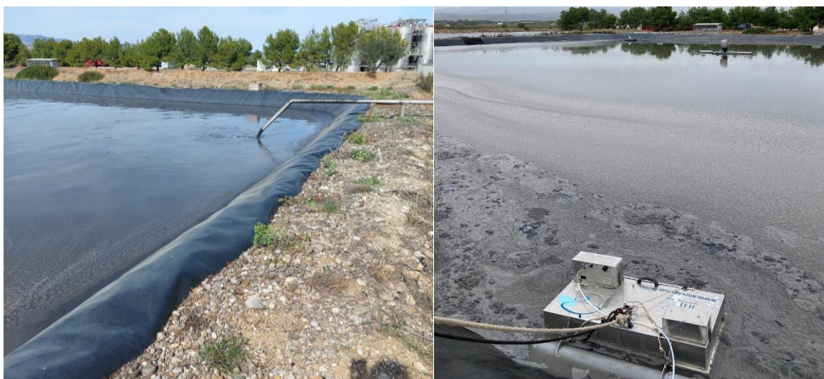
Figure 2. Entrée STEP placée dans le coin Est de la lagune / accumulation de dépôts sur le bord sud de la lagune
