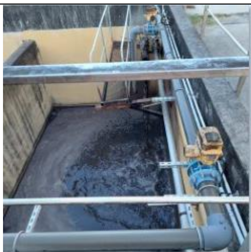
Surface du poste de relevage
