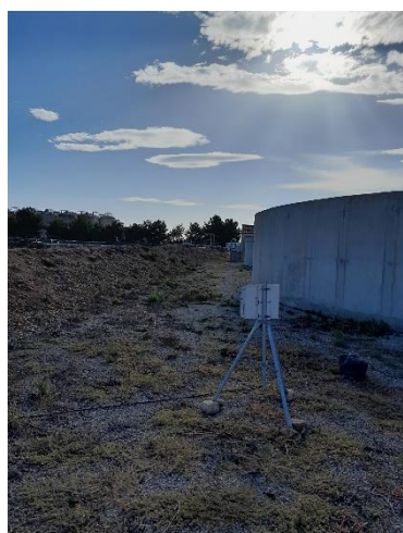
Capteur Point 2 Ouest bassin aération
